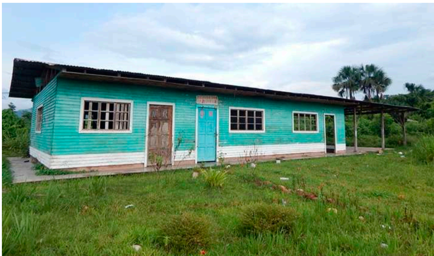
Figura 17: Vista del Pronoei y salón comunal del sector de San Luis.
