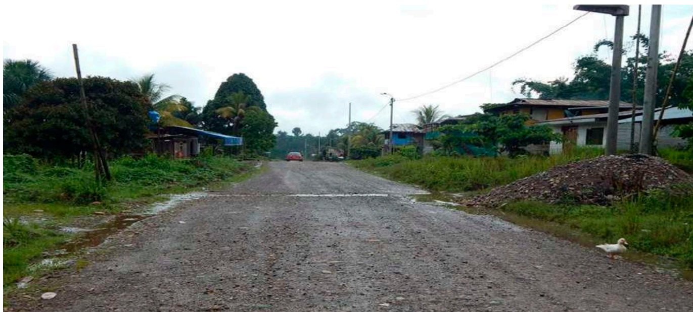
Figura 6: Vista de la carretera principal de acceso a la Comunidad, en sector Pueblo Libre.
